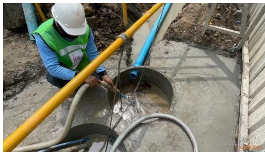
รูปที่ 19 บ่อดักดินจากการล้างล้อรถบรรทุก
